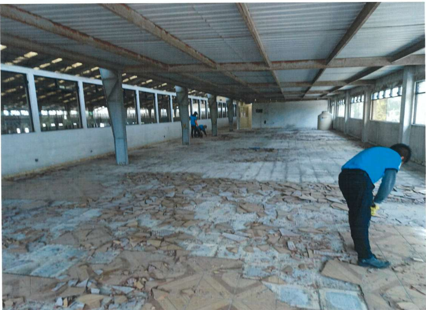
REMOCIÓN DE PISO
