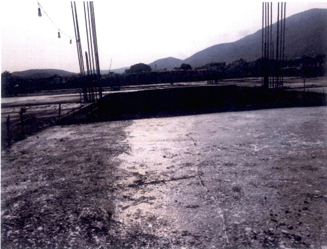
Losa edificio administrativo.
