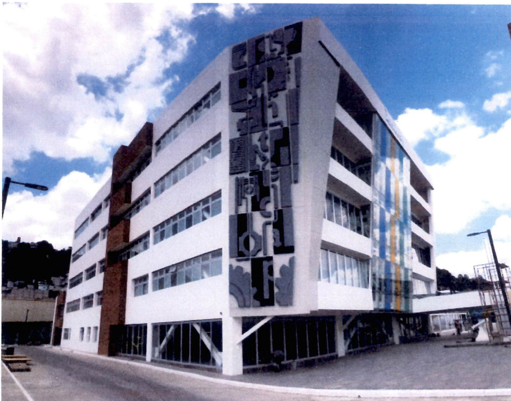
Vista Frontal del Edificio Administrativo.
