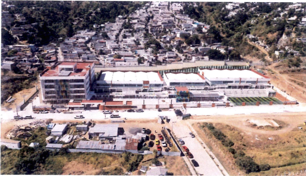
Vista de calle frontal.
