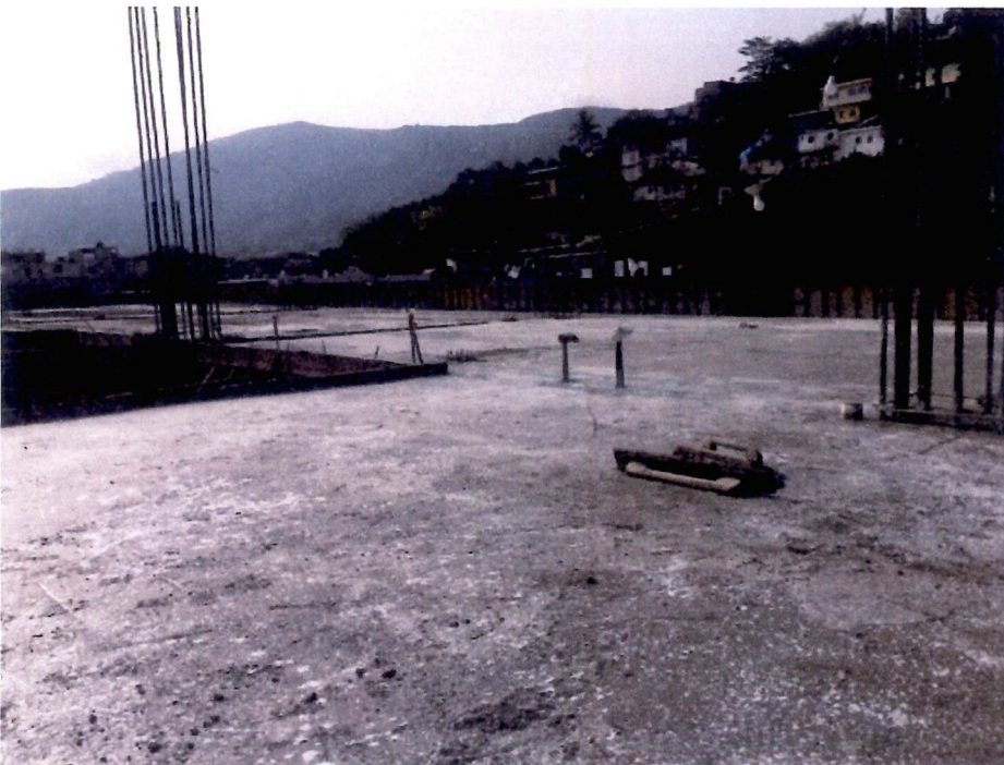
Aplicación de anti sol en Losa del edificio administrativo.
