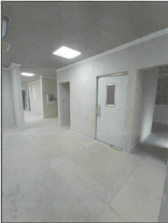
FOTOGRAFÍA 8 Y 9: Colocación de curvas sanitarias y aplicación de pintura epóxica en cocina
