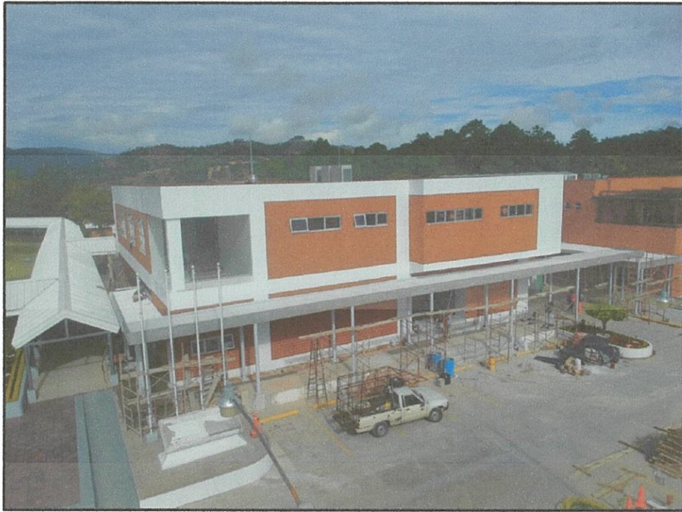
FOTOGRAFÍA 2: Vista aérea de edificio Gastronómico
