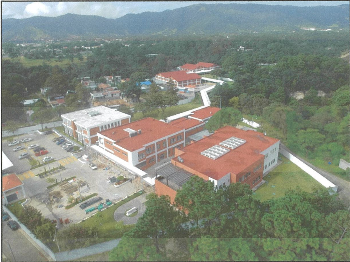
FOTOGRAFÍA 1: Vista aérea de edificio Gastronómico
