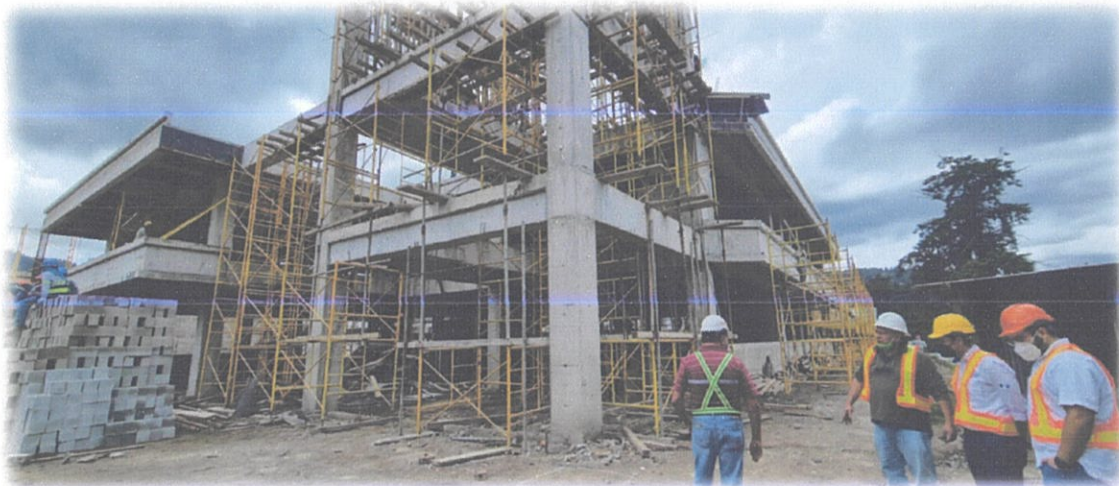
Edificio Administrativo Módulo del elevador.
