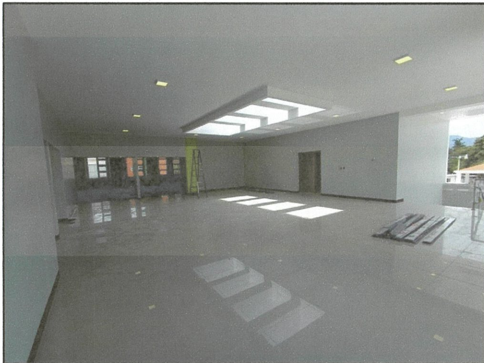
FOTOGRAFÍA 7: Vestíbulo de segundo nivel
